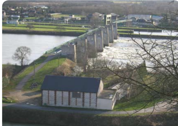
Au pied de la butte : le barrage, oeuvre, en partie, de Gustave Eiffel.
