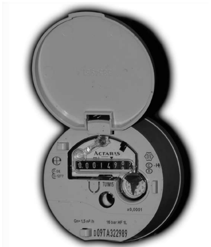
■ Remplacement des compteurs mais suppression de l'assurance fuite !
