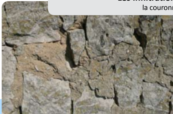
Les joints laissent passer l'eau : Des pierres ont éclaté sous l'effet du gel.
