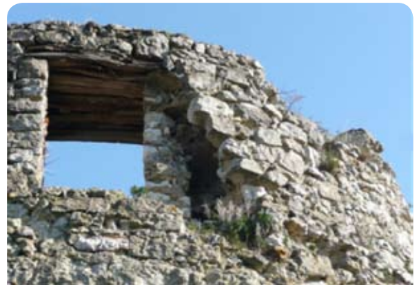
Les infiltrations ont miné la couronne et les murs.
