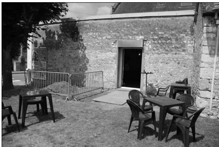
■ Juillet, l'arbre a été abattu, le terrassement a commencé...
