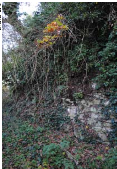
Cet amas de lierre, au fond du fossé, laisse paraître l'enpierrément de l'embase du donjon du château, qui néanmoins à cet endroit fait encore plus de 4 mètres de hauteur.
