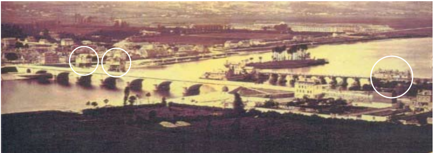
■ Vernon en 1862 : Vue sur l'ancien pont médiéval détruit, ainsi que sur le nouveau pont Napoléon III, on peut apercevoir sur la gauche deux moulins encore debout, il ne reste plus aujourd'hui que celui des Tourelles, à droite.
