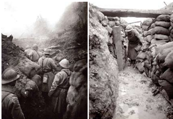
■ Tranchées aux alentours de Craonne.
