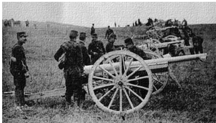
■ Le canon français de 75 modèle 1897 : équipé entre autre d'un frein de recul hydropneumatique, capable de tirer 20 coups par minute et d'une portée utile de 4 000 m, ses caractéristiques le firent surnommer le « canon roi ».
