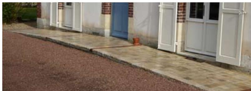
La bordure de l'accès PMR côté cour était en piteux état et a été réhabilitée : tronçonnage de la partie "malade", coffrage, pose des nouvelles bordures et briques de parement et gravillonnage.
